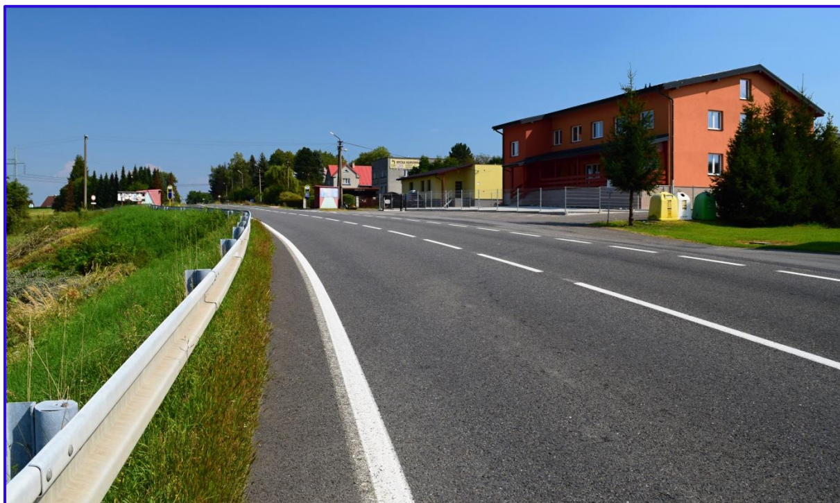
Obrázek č. 18: Silnice č. II/648
