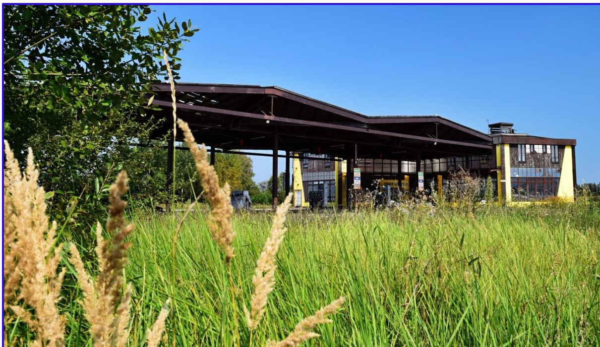
Obrázek č. 29: Bývalá čerpací stanice
