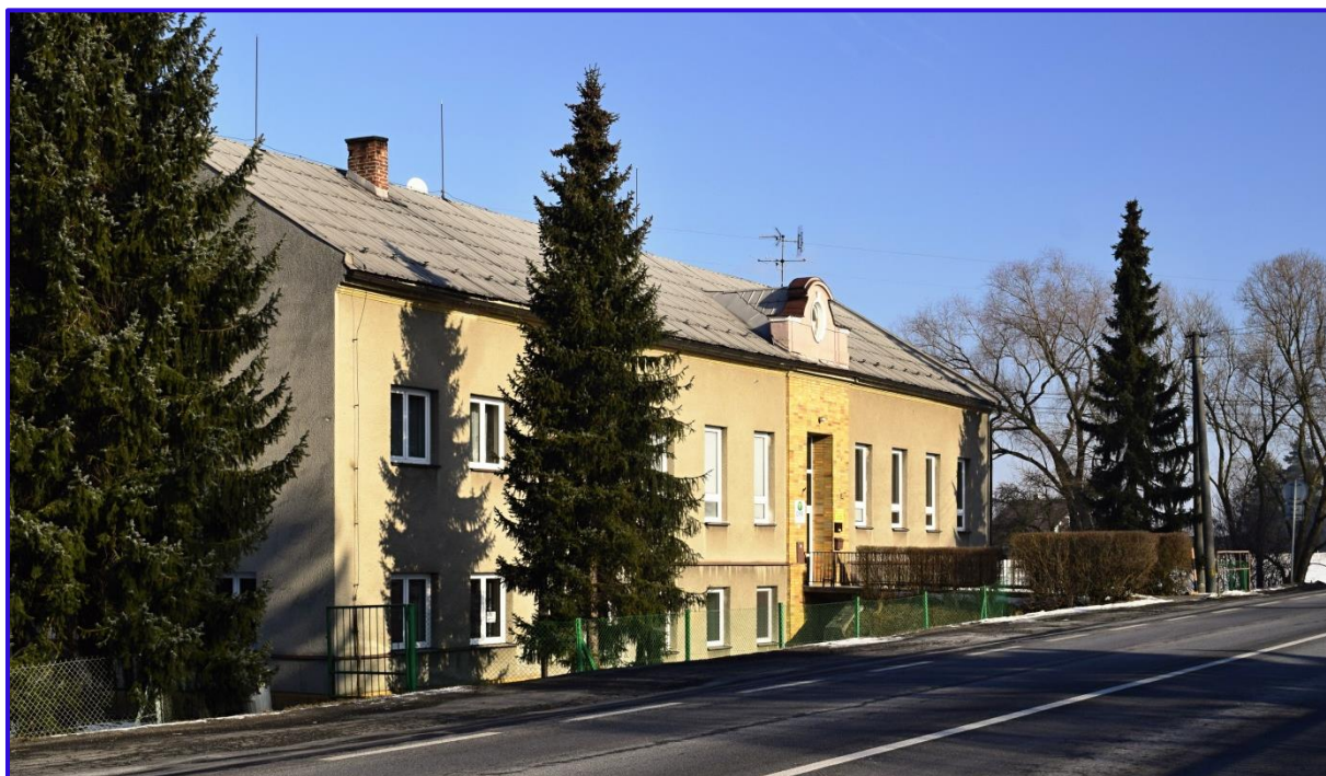
Obrázek č. 33: Budova bývalé školy
