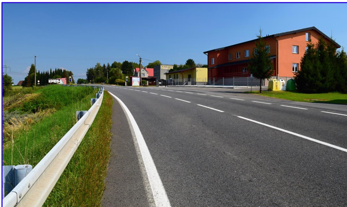
Obrázek č. 18: Silnice č. II/648
